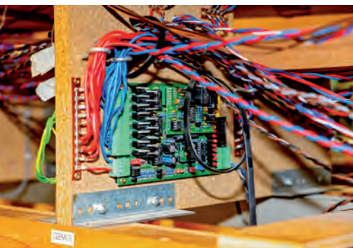
Die Gleisbelegungen werden mit einigen 16-fach-Loconet-Meldern von Blücher Elektronik erfasst.
